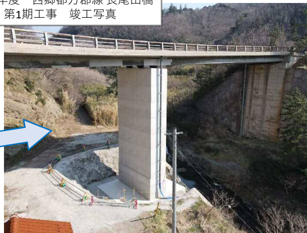
橋脚巻立部 Con打設状況
