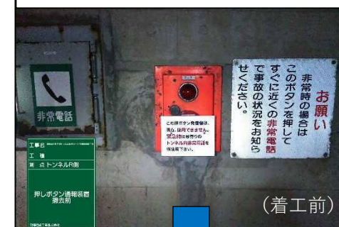
◆国道485号 非常用設備修繕工事 (五箇トン所)
