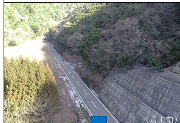
◆令和4年度竣工 中村津戸港線（原田工区）
