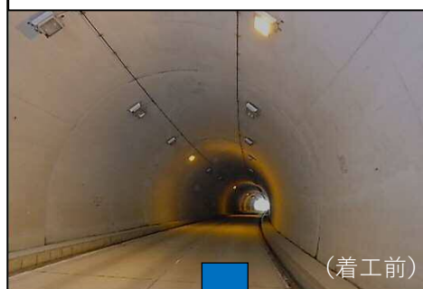
◆国道485号 LED化工事 (青稜トンネル)
