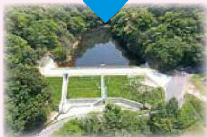
〈ため池の改修（出雲市）〉
