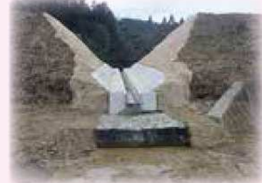
〈ため池の廃止（松江市）〉
