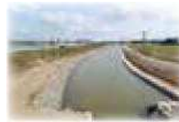
水利施設整備
