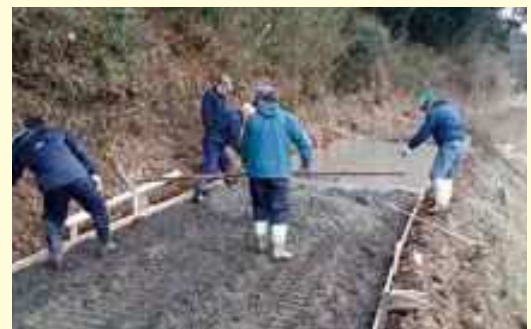
農道をコンクリートで舗装しています。
