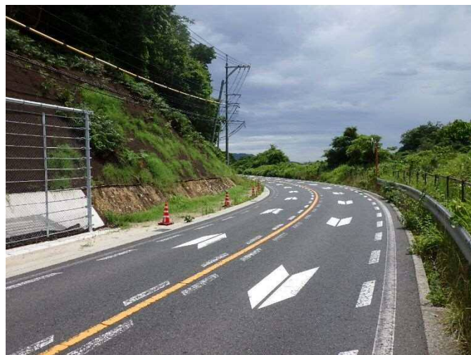
国道431号森山工区 落石防護柵着手前
