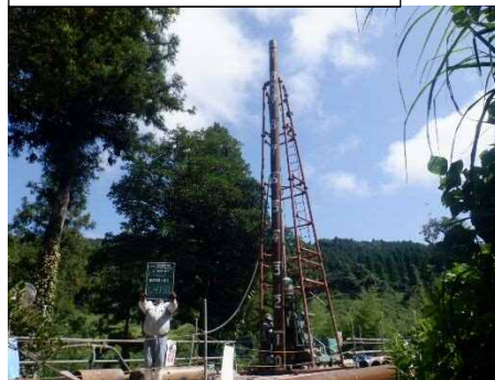
抑止工（杭工 施工中）
