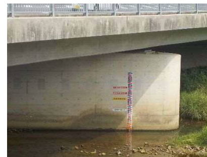
神納橋（八雲町）量水標確認
