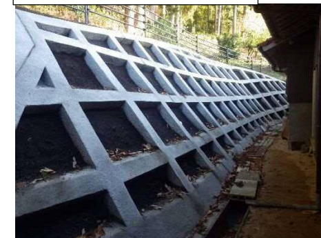
斜面改良工（法枠工）
