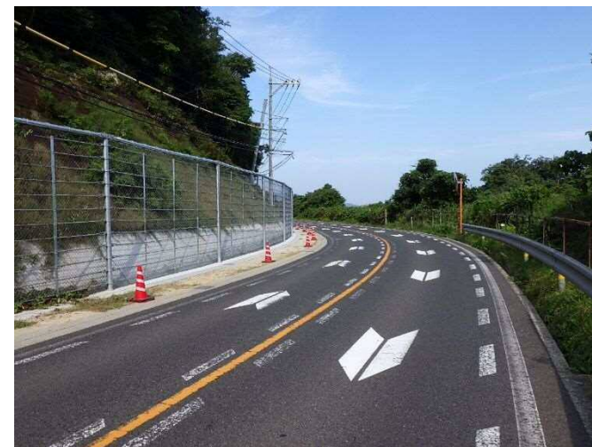
国道431号森山工区 落石防護柵完成
