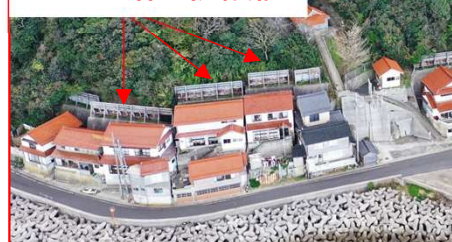
逆Y型落石防護柵
