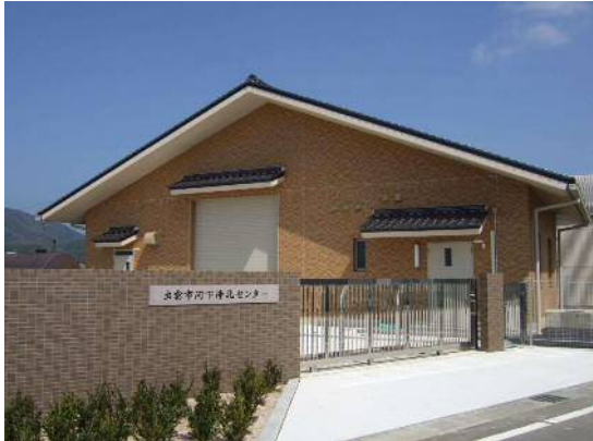
河下浄化センター（出雲市）
