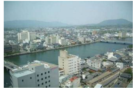
駐車場整備地区（松江市）
