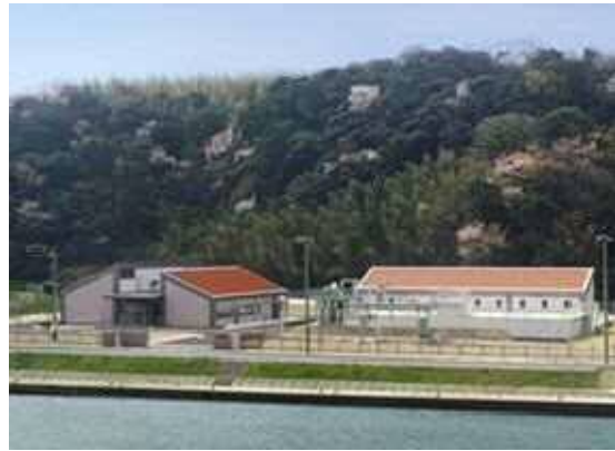
国府浄化センター（浜田市）
