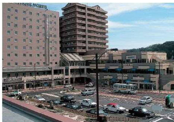
益田駅前地区第一種市街地再開発事業（益田市）
