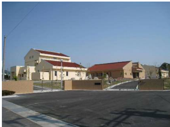
大田浄化センター（大田市）
