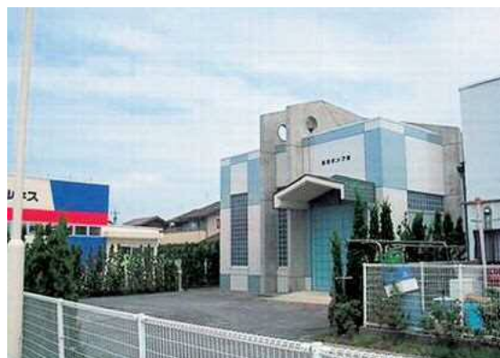
黒田中継ポンプ場（松江市）
