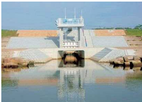
万葉都市下水路樋門（益田市）
