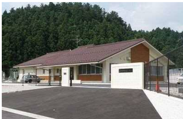
西郷浄化センター（隠岐の島町）
