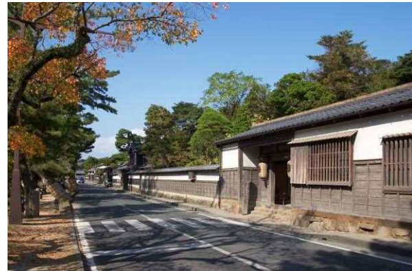
景観地区（松江市）
