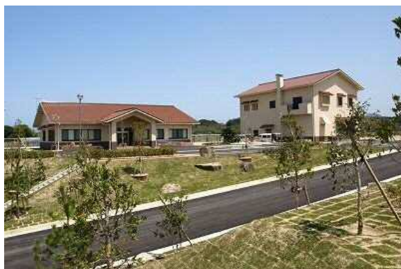
益田水質管理センター（益田市）
