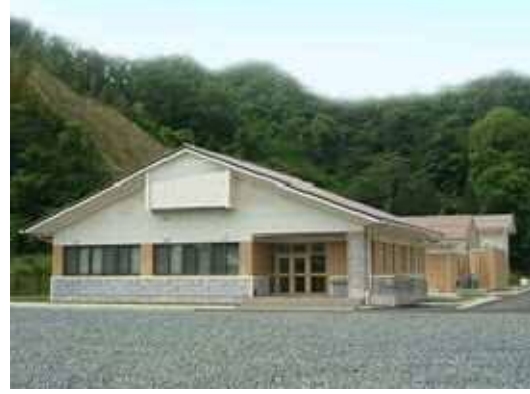
大東浄化センター（雲南市）
