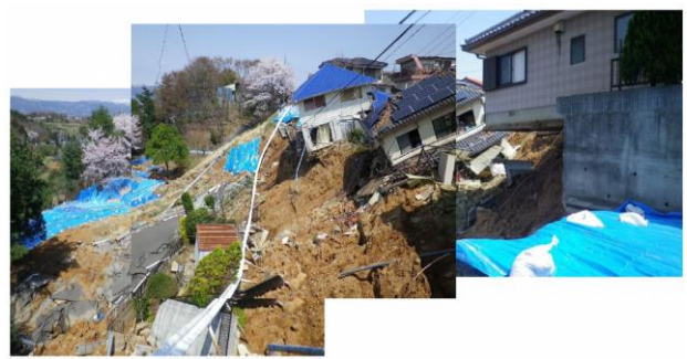
(d)液状化による側方流動
