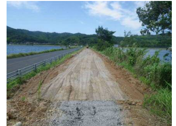
終点側から起点側を望む
