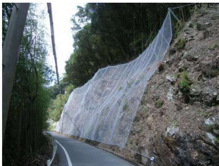
図-2 実施例（落石防護網）
