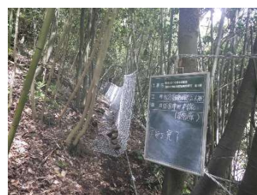
立木柵 (主) 温泉津川本線 (川本町)
