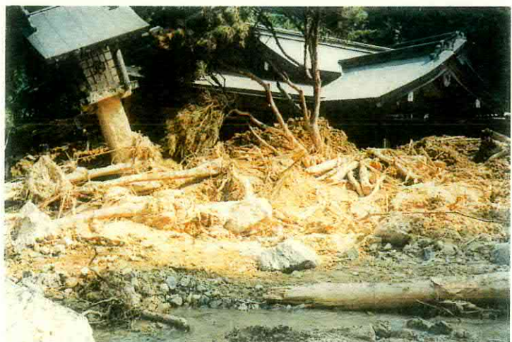
土石流に襲われた三隅神社（那賀郡三隅町）
