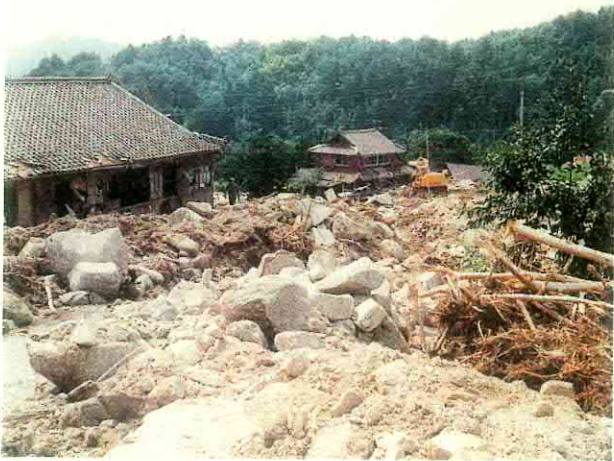
土石流に襲われた家屋（益田市）
