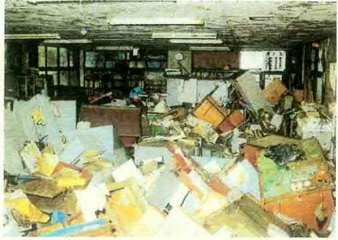
水が引いた後の三隅町役場の散乱状態
