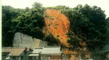
土砂災害に襲われた三隅町須津地区
