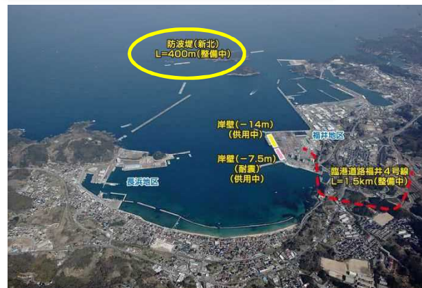
浜田港 新北防波堤の整備状況
