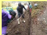
水路の泥上げ
