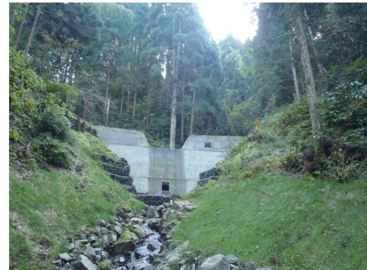
[土砂流出防備保安林] 谷止工
