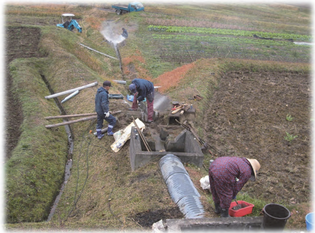
集落の営農を支える共同活動（水路補修作業・浜田市）
