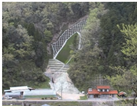
■治山事業（山腹工 注2 、治山ダム工）
