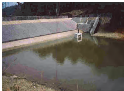
ため池の改修
