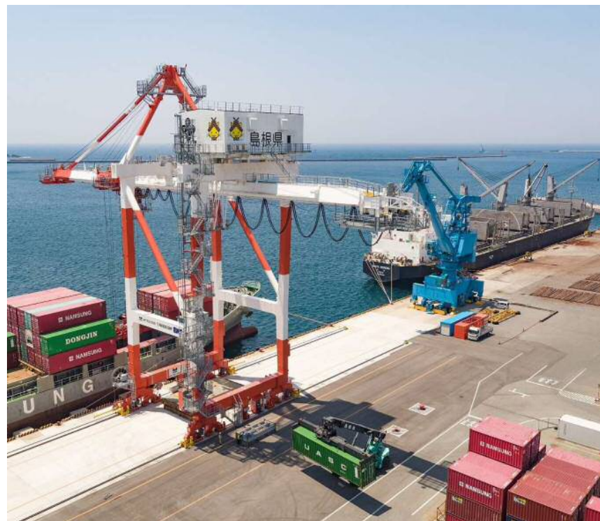
平成30年に新設されたガントリークレーン
