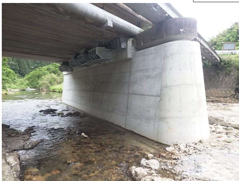
橋脚巻立補強
