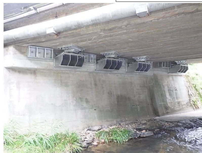
落橋防止装置・水平力分担構造
