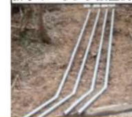
排水ボーリング設置例
