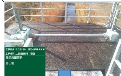
R6施工 二貫田樋門 開閉装置更新
