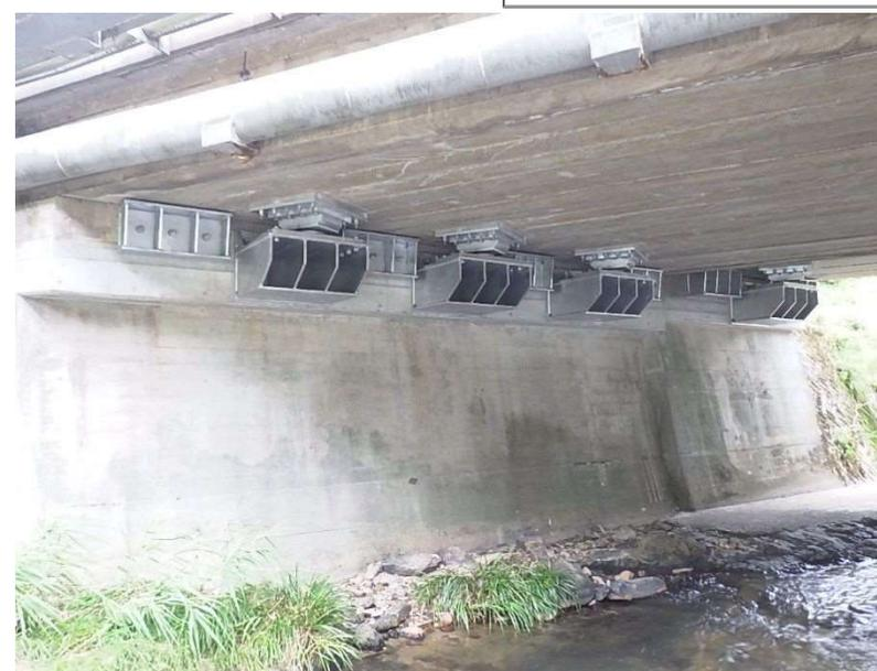
落橋防止装置・水平力分担構造
