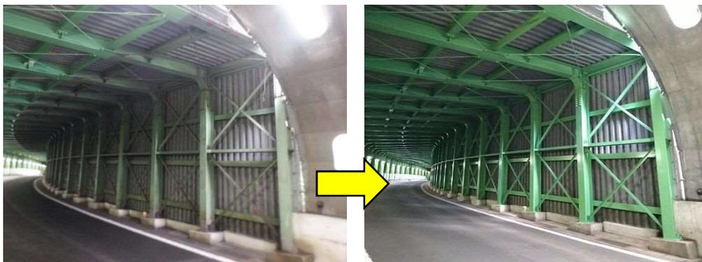
R5 施工 角井防雪坑 梁塗装塗替
