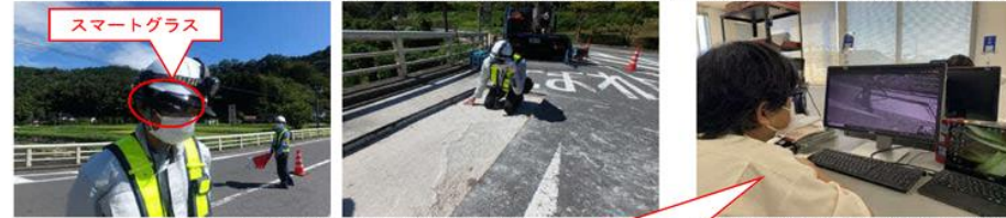
スマートグラスを着用した現場作業状況
