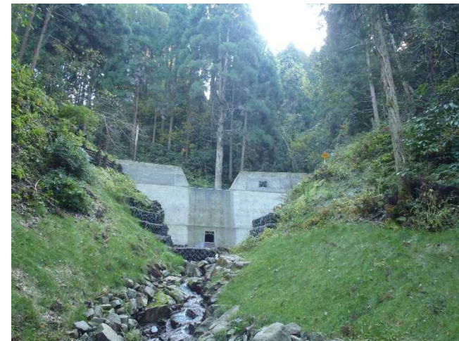
〔土砂流出防備保安林〕 谷止工
