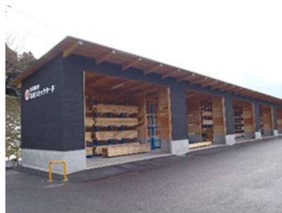
〔島根県産木材ストックヤード〕 出雲木材市場内
