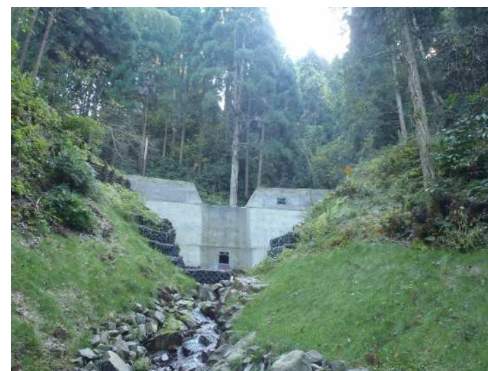
[土砂流出防備保安林] 谷止工
