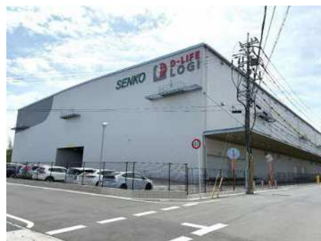
佐賀県鳥栖市（大型物流施設）
