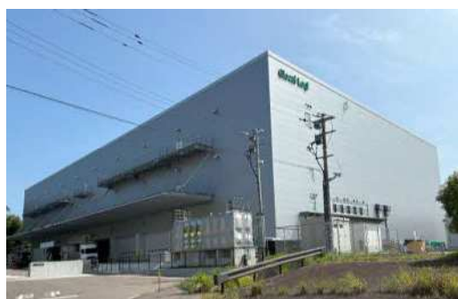
佐賀県基山町（大型物流施設）
