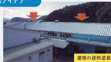
屋根の遮熱塗装
