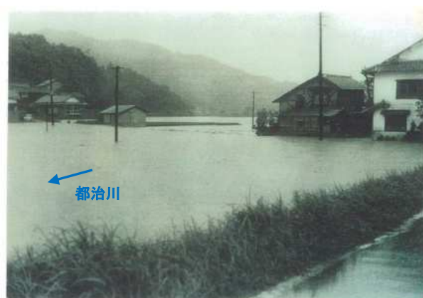
昭和 46 年 7 月豪雨被災状況
