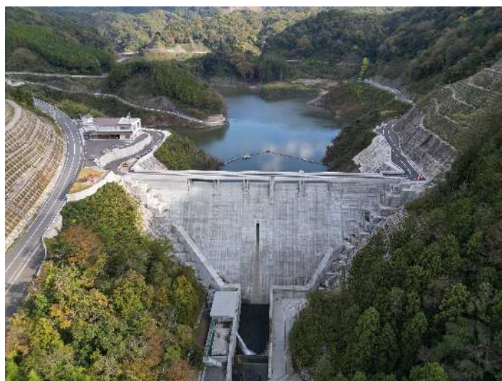
波積ダム全景
