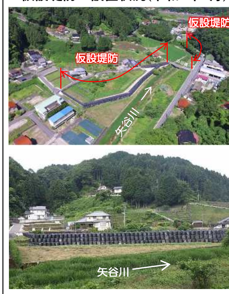
仮設堤防の設置状況(令和4年8月)
