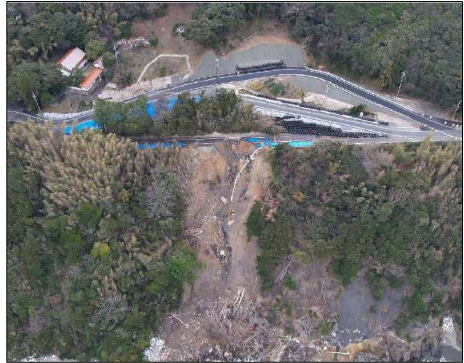
【仮設迂回道路の整備状況】
