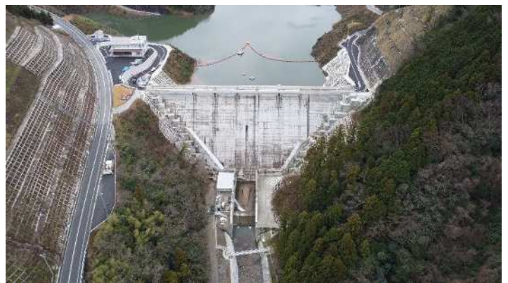
波積ダム状況写真（令和 6 年 2 月末）
