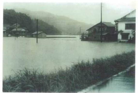
昭和 46 年 7 月豪雨被災状況
