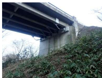
落橋防止構造
