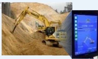
3Dデータを利用した機械施工
