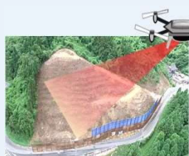
ドローンによる3D測量
