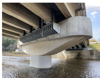
水平力分担構造
