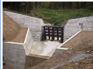
砂防堰堤工
