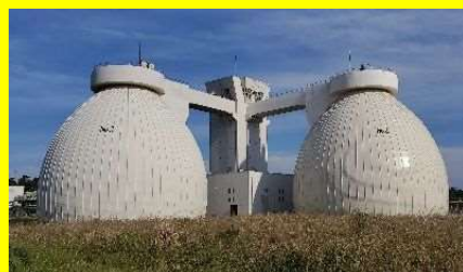
汚泥消化タンク 【西部浄化センター】
