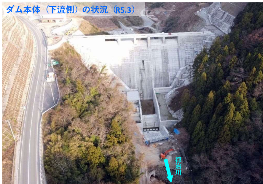
ダム本体 (上流側) の状況 (R5.3)
