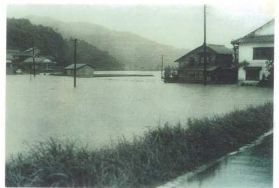
昭和46年7月豪雨被災状況
