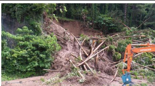
①山腹崩壊により迂回路のない町道に土砂流出、倒木により小屋の一部が損壊
