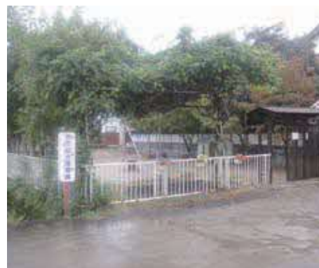
＜施設外観（正面入口）＞
