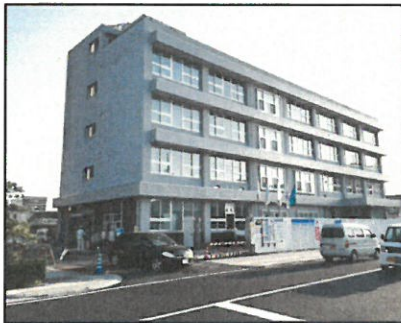
第二分庁舎外観
