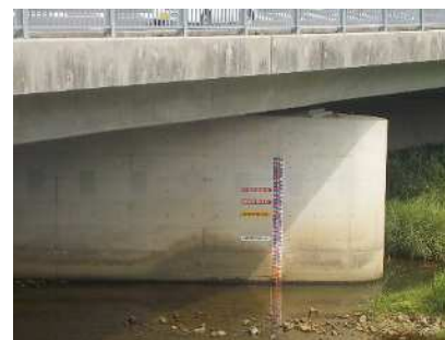
神納橋（八雲町）量水標確認
