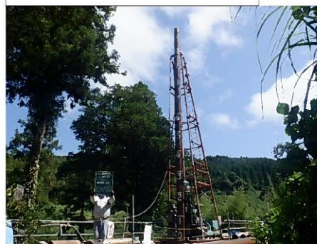
抑止工（杭工 施工中）
