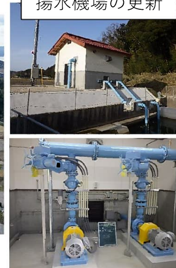
揚水機場の更新
