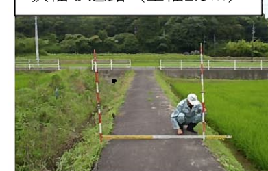
狭幅な道路（全幅2.0m）
