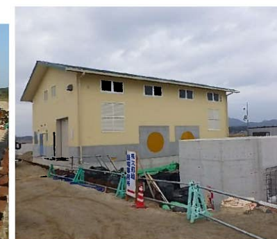
排水機場建屋
