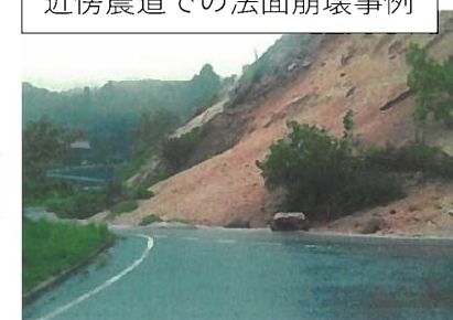
近傍農道での法面崩壊事例
