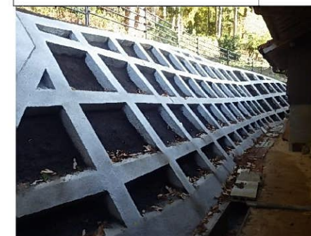
斜面改良工（法枠工）
