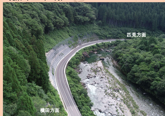
③国道488号 (落合工区) 完成 (R6年7月)
