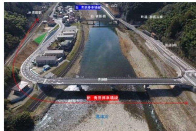
← 新橋完成状況
