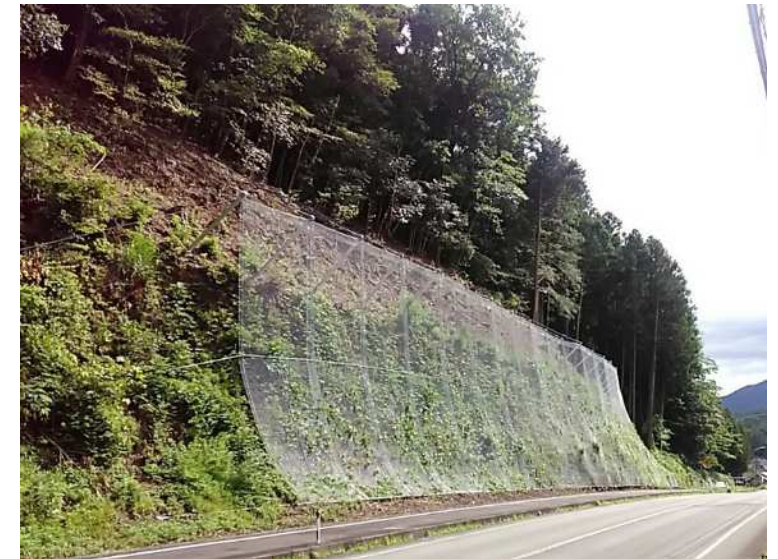
落石防護網設置 国道191号 美都町丸茂地内
