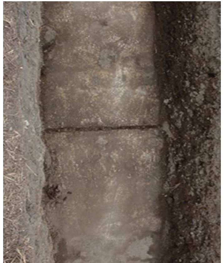
コンクリートの目地 (1)
