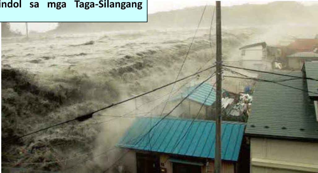
Sinira ng Tsunami ang Pilapil (small dike)
