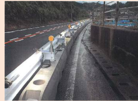
仮歩道の状況 10月19日
