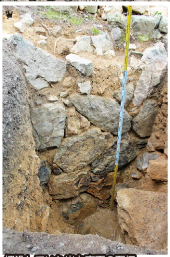
埋没していた出丸南面の石垣
