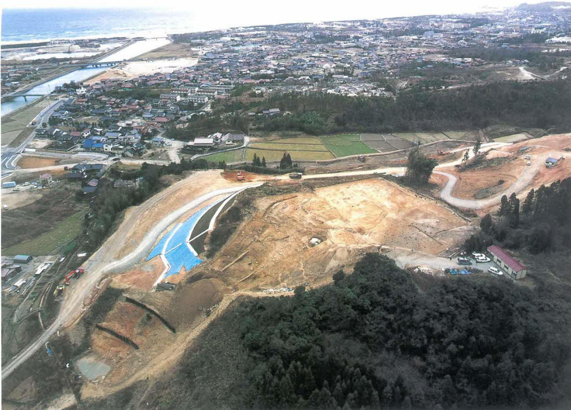
写真 2 古八幡付近遺跡 8 区全景
