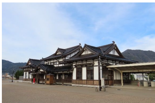
修理完成状況
