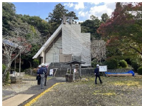
収蔵庫屋根葺替作業
