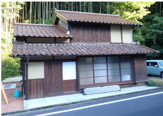
（山根家主屋 保存修理後）
