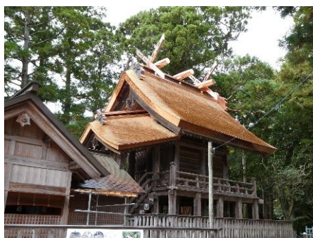
修理完成状況
