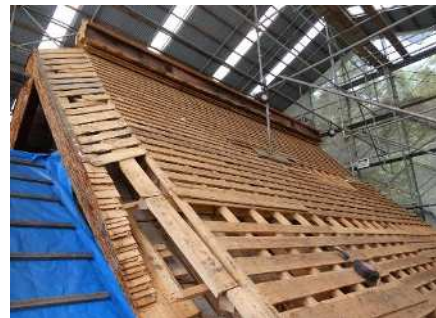
本殿屋根の葺き替え作業
