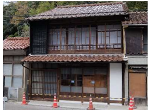
（恵珙寺離れ 保存修理後）
