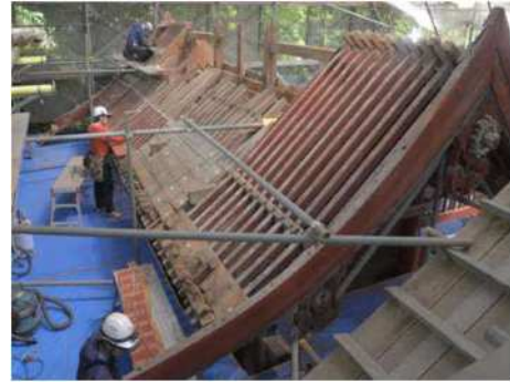
本殿屋根の解体作業
