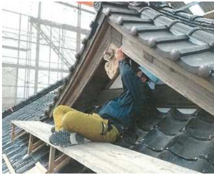
新調懸魚 げぎよ の取り付け作業
