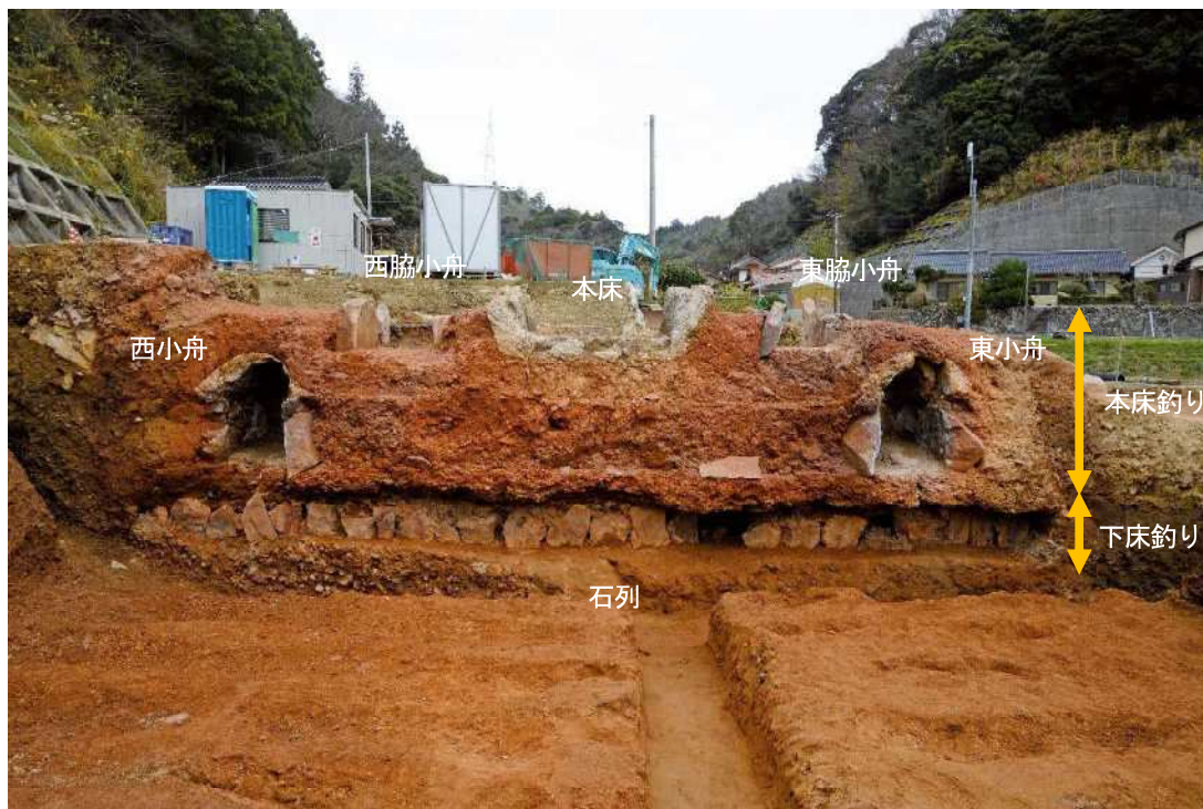
図6 地下構造の断面
