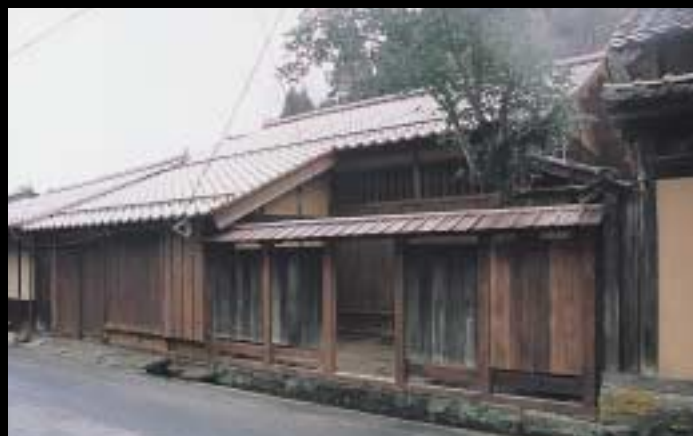
修理後 痕跡や板図により左側の間口2間半・奥行き1間半は後の増築ということが分かりました。
