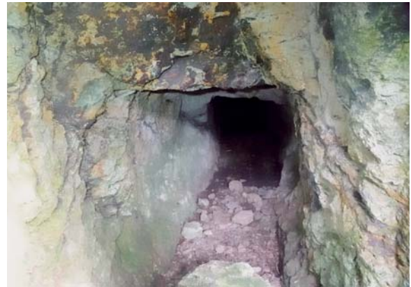
写真8 間歩番号393の坑内
