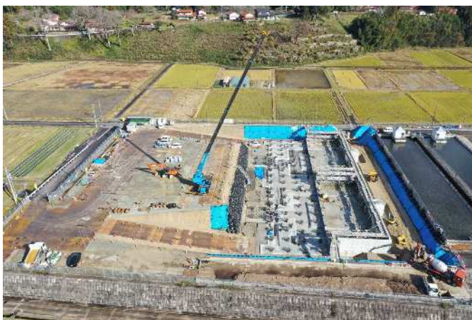
緩速ろ過池増設 施工状況
