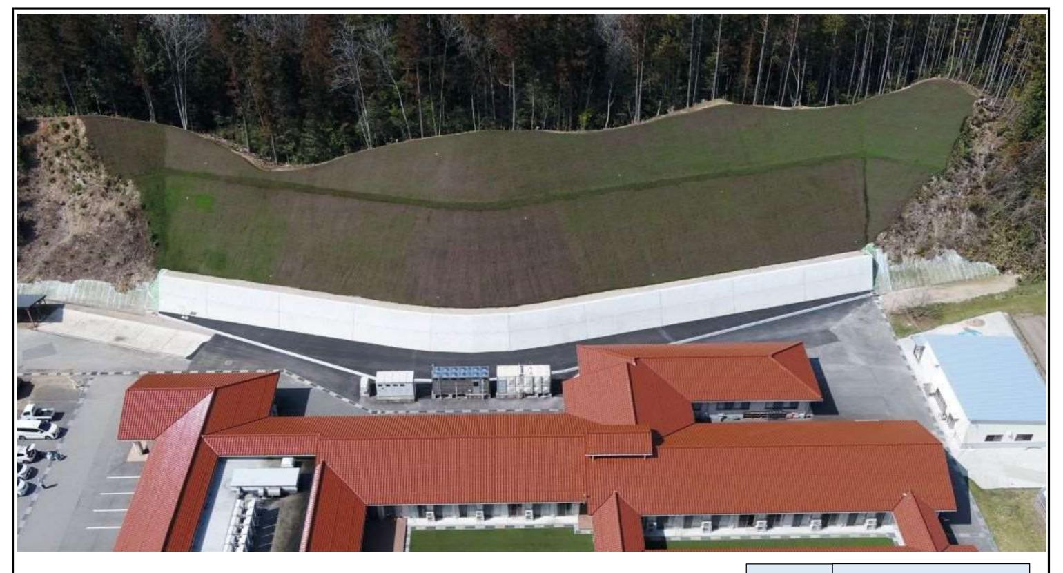
掘削工 V=1,510m3 もたれ式擁壁 L=96.13m 植生基材吹付工 A=2,590m2
