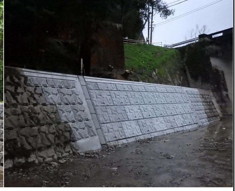
3災第726号 工事延長 L=27.6m コンクリートブロック積工 A=74m2 根固めブロック工 N=33個
