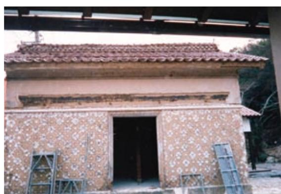
下屋根撤去・外壁仕上げ撤去の状態
