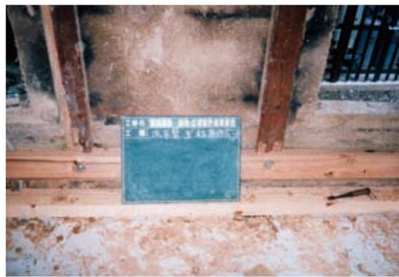
内部側に新規土台・水平繋ぎ貫材の設置
