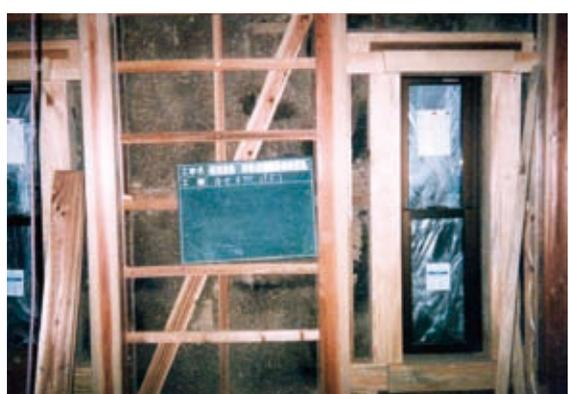
内部側添え柱・筋かい設置
