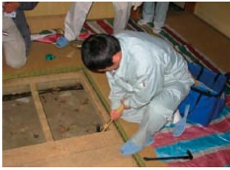
床下から基礎の位置やひび割れなどの状態、土台の腐朽などの状態を確認しました。
